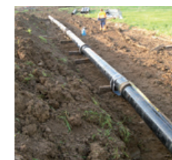
Smontované trubky STANDARD TT-PE DIREXIONAL připravené k zatažení
