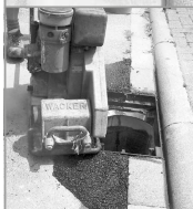
Abschluss- und Asphaltarbeiten
