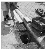
Ausbau des Aufsatzes
