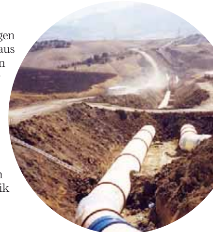
▲ Rohrleitungsprojekt zur Wasserversorgung der Städte Algier und Tizi-Ouzou.
