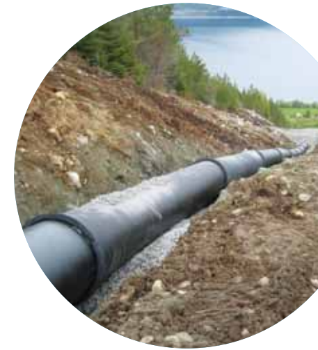
▲ Bau einer Druckleitung, Projekt in Norwegen.
