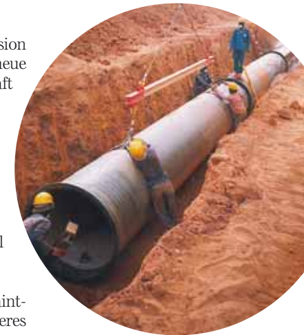
▲ Einbau einer Rohrleitung für die Trinkwasserversorgung
