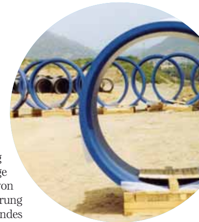
▲ Formstücke aus duktilem Gusseisen. Baustelle in Mauretanien
