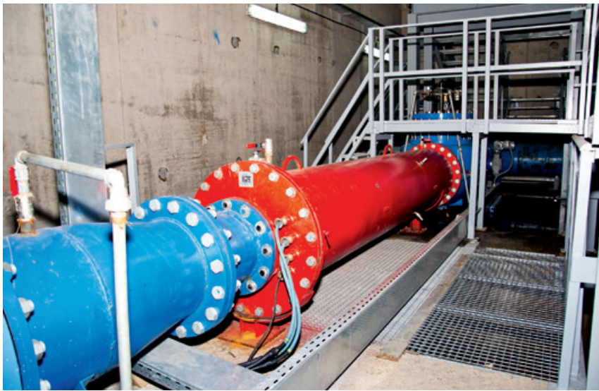
Abb. 4: Bei der Wasserversorgung der spanischen Hauptstadt Madrid kommen mehrere Mikroturbinen zum Einsatz.
