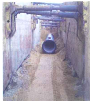
Offene Verlegung der Gussrohre.
