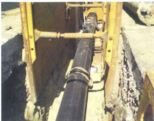
Offene Verlegung der Gussrohre.
