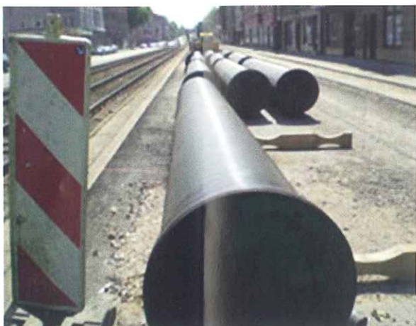
Sanierung der Stahlleitung.
