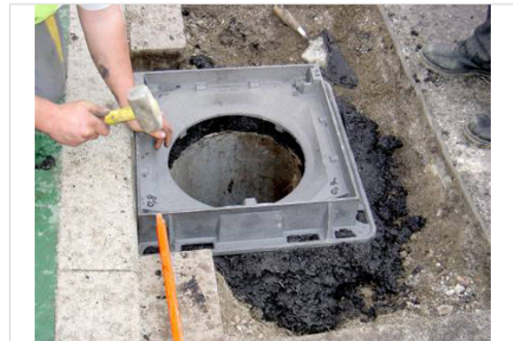
2- Colocación del marco.
