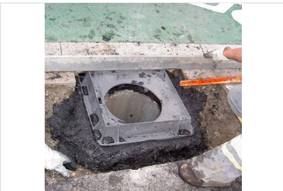
3- Ajuste del nivel del marco.
