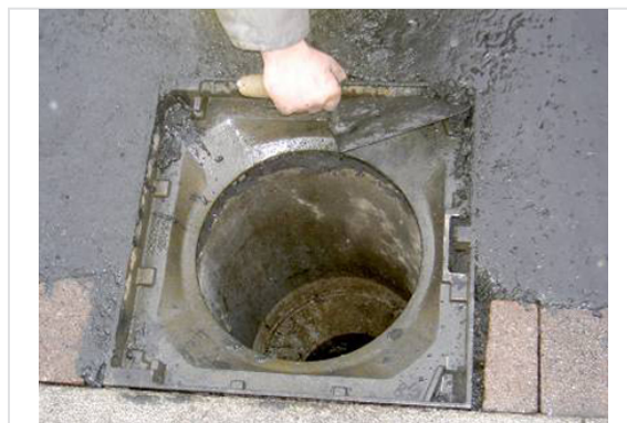
5- Limpieza de los apoyos.
