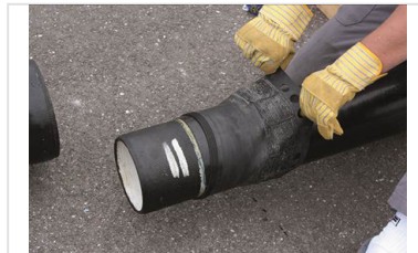
2 -Hacer deslizar el manguito sobre ... brida-liso de la tubería
