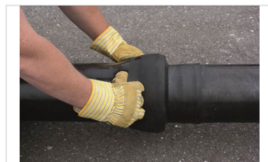
5- Ajustar el manguito sobre el enchufe para proteger la junta
