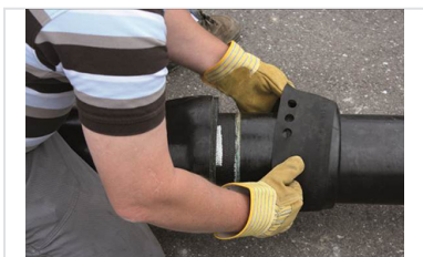
4- Volver a colocar el manguito
