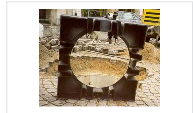
Registro PAMREX 600 Clase D 400 - Instalación de un registro con marco aparente
