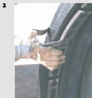
>> Colocación de acopladores
