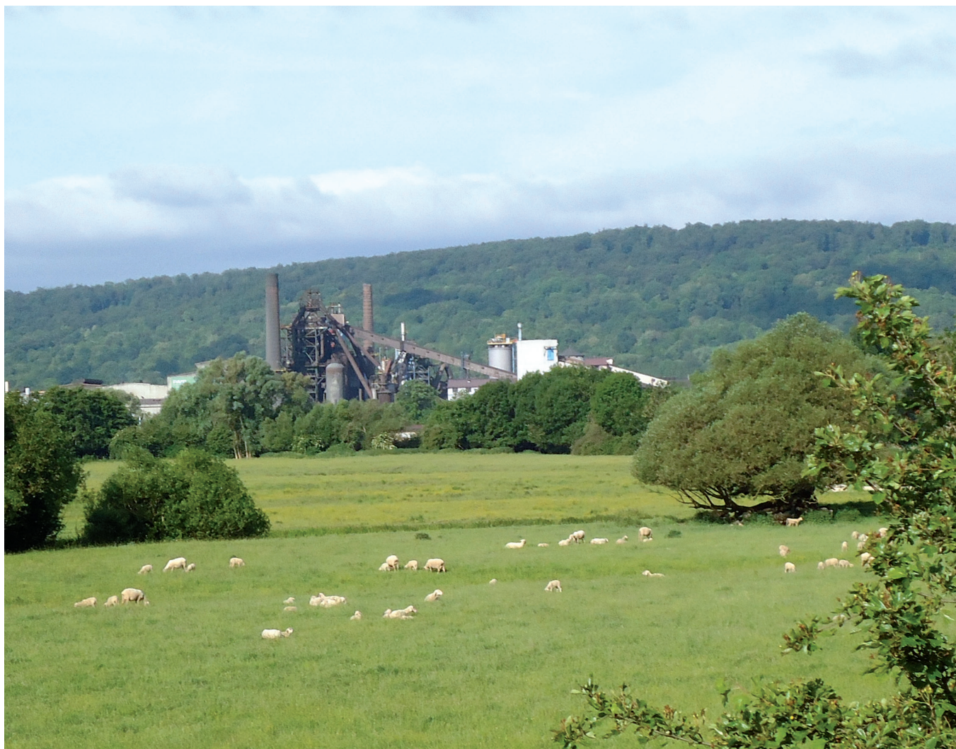
Saint-Gobain PAM Canalisation - Usine de Pont-à-Mousson
