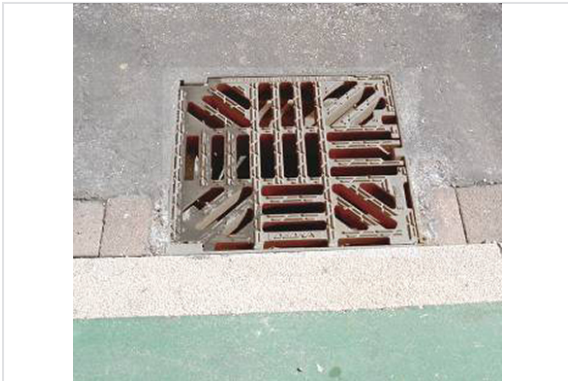
6- Grille en place.
