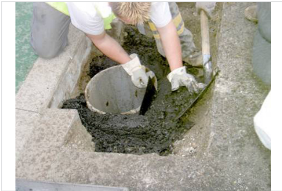
1- Mise en place du produit de scellement - Tuyau PVC DN400
