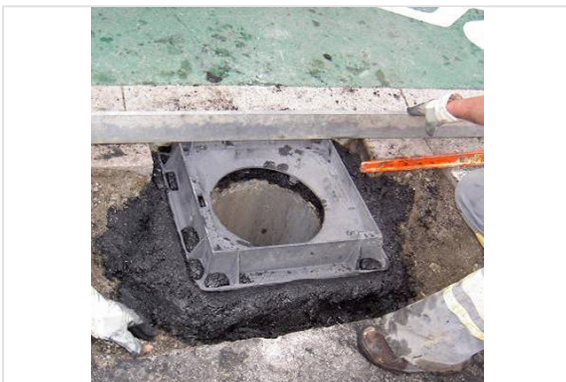
3- Mise à niveau du cadre.
