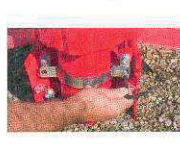
Respecter le positionnement angulaire du coffre par rapport au corps du Poteau d'Incendie, aux prises
