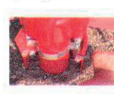
Respecter le positionnement angulaire du coffre par rapport au corps du Poteau d'Incendie, aux prises
