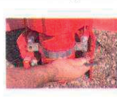
Respecter le positionnement angulaire du coffre par rapport au corps du Poteau d'Incendie, aux prises
