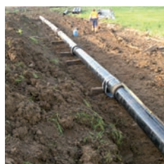
Train de tuyaux TT PE avant tirage par forage dirigé
