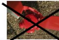
Respecter le positionnement angulaire du coffre par rapport au corps du Poteau d'Incendie, aux prises
