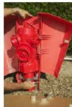
Respecter le positionnement angulaire du coffre par rapport au corps du Poteau d'Incendie, aux prises
