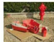
Dépose du socle avant
