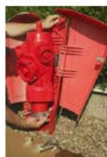
Maintenir le coffre « debout » à main gauche, disposer le 1/2 collier avant supérieur et serrer les vis avec la clé disposée dans le sachet
