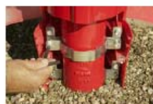
Maintenir le coffre « debout » à main gauche, disposer le 1/2 collier avant supérieur et serrer les vis avec la clé disposée dans le sachet
