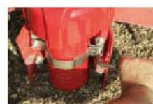
Maintenir le coffre « debout » à main gauche, disposer le 1/2 collier avant supérieur et serrer les vis avec la clé disposée dans le sachet
