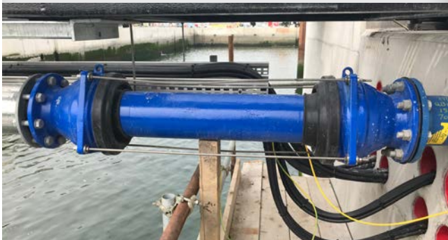
Pose en entrée/sortie d'un aqueduc
