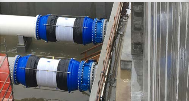
Pose en entrée/sortie d'un réservoir
