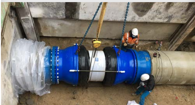
Pose en entrée/sortie de chambre de vanne
