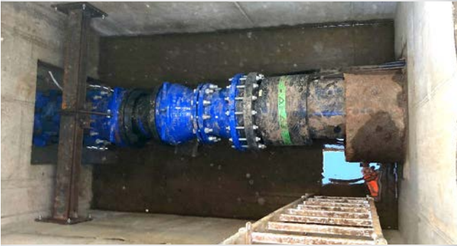
Pose en sortie de passage en fourreau
