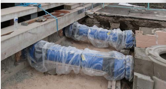
Pose en limite de structure
