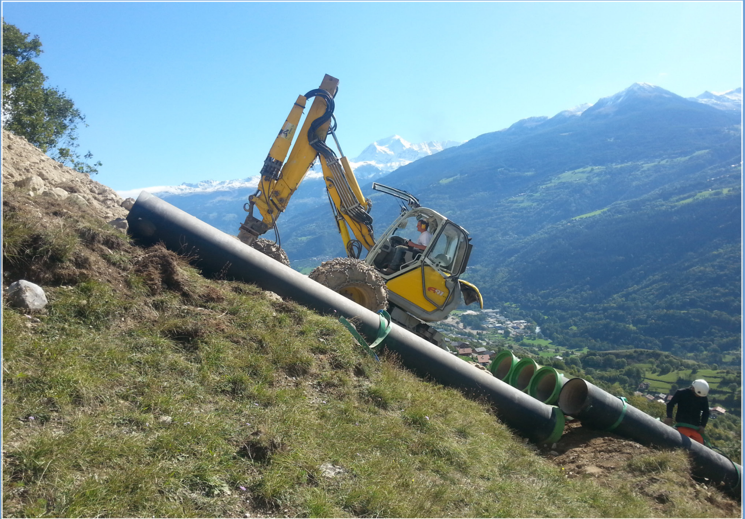
Chantier AIME (73) | DN 500mm | 1400ml linéaire | MO : THE
