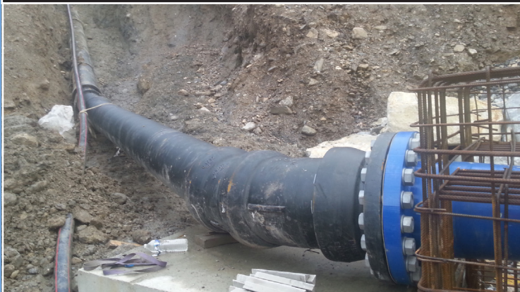
Chantier AIME (73) | DN 500mm | 1400ml linéaire | MO : THE
