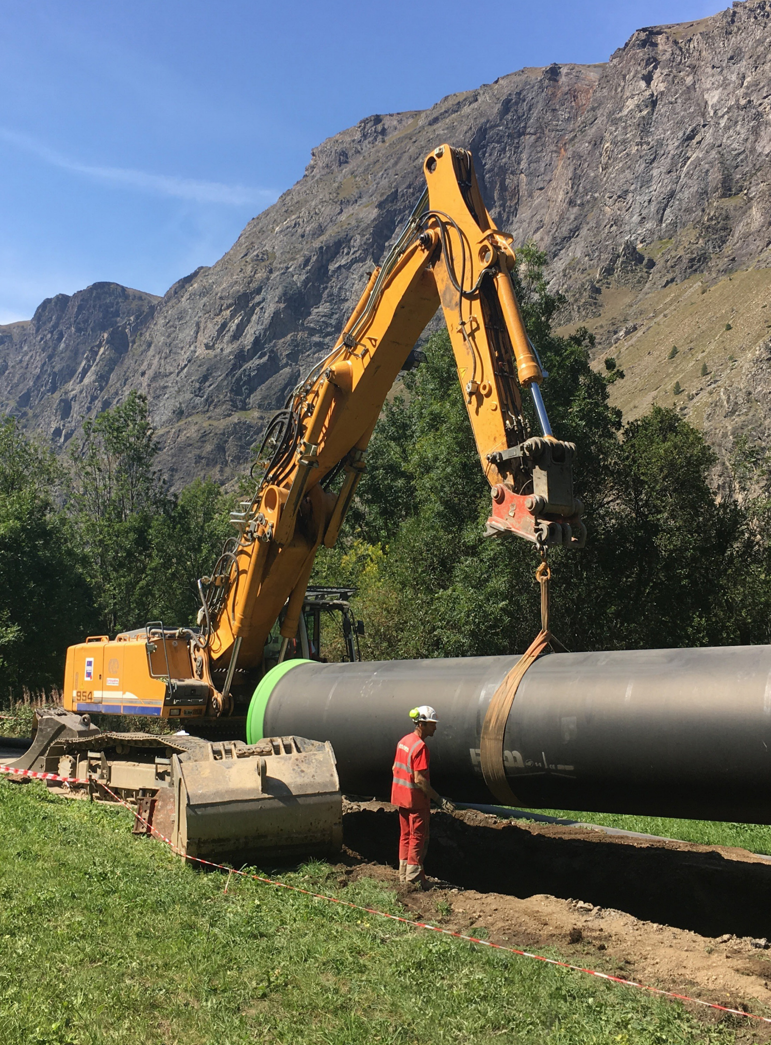
Chantier la Meije | DN 1400 et DN 1600 | 2017-2018
