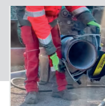
TAGLIO DI UN TUBO IN UNO SCAVO
