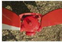
Respecter le positionnement angulaire du coffre par rapport au corps du Poteau d'Incendie, aux poises
