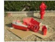
Dépose du socle avant
