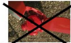
Respecter le positionnement angulaire du coffre par rapport au corps du Poteau d'Incendie, aux poises
