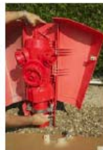
Respecter le positionnement angulaire du coffre par rapport au corps du Poteau d'Incendie, aux poises
