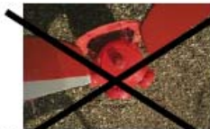
Respecter le positionnement angulaire du coffre par rapport au corps du Poteau d'Incendie, aux prises
