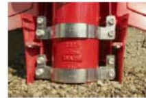
Disposer dans un 2 ème temps, le 1/2 collier avant inférieur et serrer les 2 vis, comme précédemment
