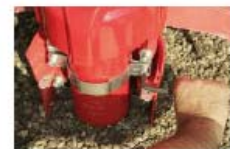
Maintenir le coffre « debout » à main gauche, disposer le 1/2 collier avant supérieur et serrer les vis avec la clé disposée dans le sachet
