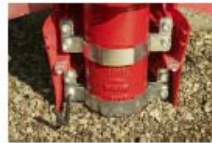
Disposer dans un 2 ème temps, le 1/2 collier avant inférieur et serrer les 2 vis, comme précédemment
