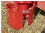
Mise en place du socle avant
