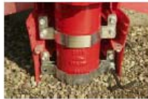
Disposer dans un 2 ème temps, le 1/2 collier avant inférieur et serrer les 2 vis, comme précédemment
