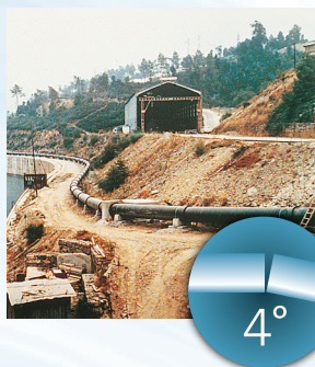
Odchylenie kątowe minimum 4° dla złączy STANDARD do DN 1200
