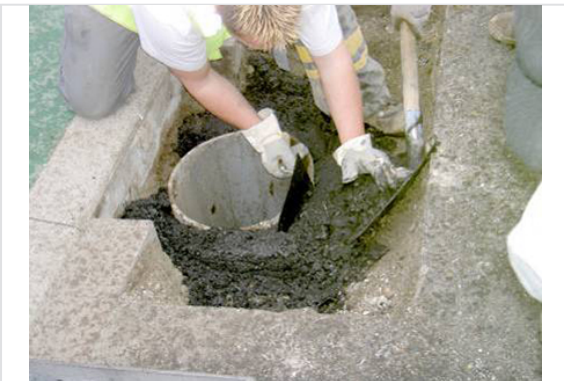
1- Aplicación del producto de sellad... Tubo PVC DN400
