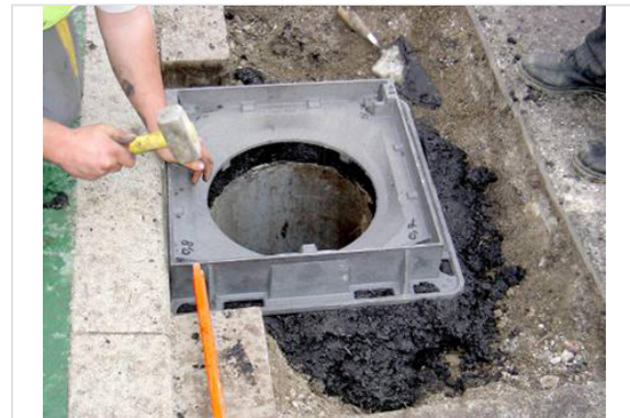
2- Colocación del marco.
