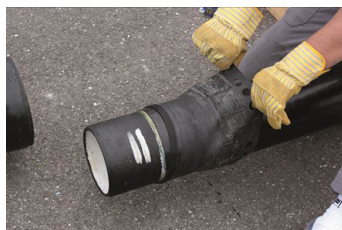
2 -Hacer deslizar el manguito sob... la brida-liso de la tubería
