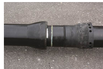
3- Embalar las tuberías
