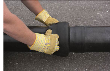
5- Ajustar el manguito sobre el enchufe para proteger la junta
