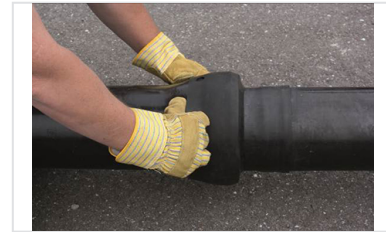
5- Rabattre la manchette sur l'emboîture pour protéger la jonction
